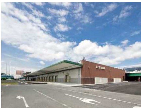
加工場・冷蔵庫棟
